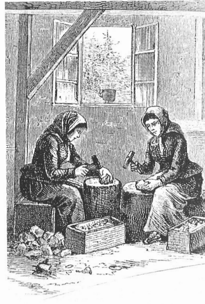
1 Úprava křemene v 19. století. Ženy rozbíjejí vypálené kusy křemene a odstraňují železité, zbarvené žilky.
