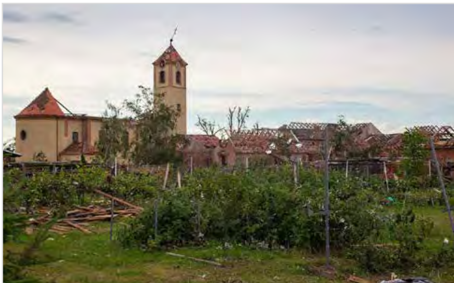
Obr. 10 Poškozený kostel sv. Jakuba a okolní domy v Moravské Nové Vsi (zdroj: [11]; autor: Tadeáš Bednarz – Vlastní dílo, CC BY-SA 4.0, https://commons.wikimedia.org/w/index.php?curid=106990494 )
