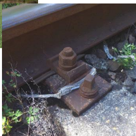
železniční násep se svlečkou u. hladké
