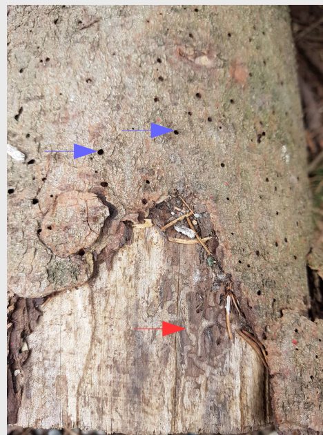
Výletové otvory (modře) a požerky (červeně) způsobené hmyzem
