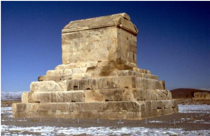
Mausoleum v Pasargadae (Persie, 6 st.př.n.l.) Nejstarší stavba s konstrukčními prvky odpovídajícími "base isolation" systému.
