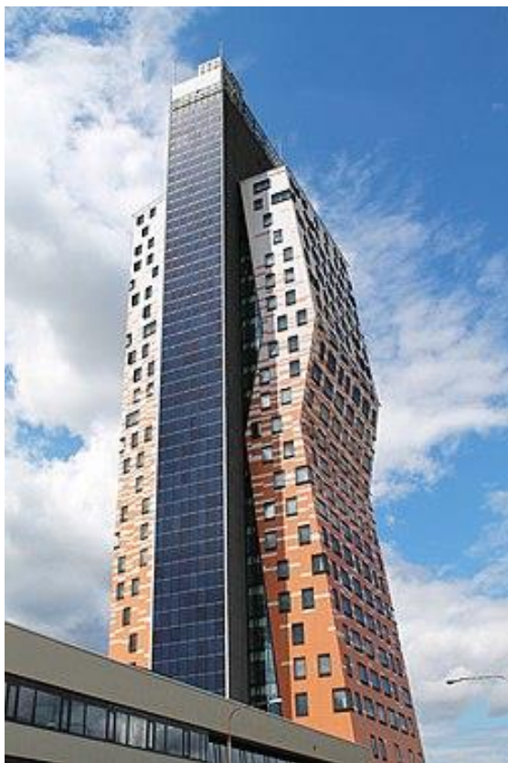
AZ Tower, Brno střecha 111 m
