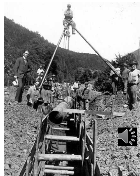
I. březovský vodovod, kladení potrubí, rok 1912 (bvk.cz)
