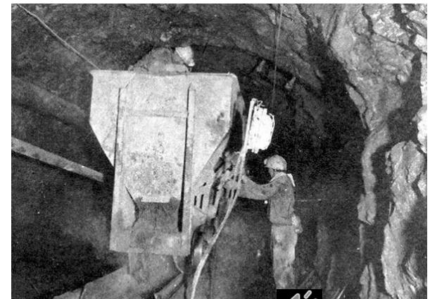
Výstavba štolového přivaděče z ÚV Želivka (cistavoda.pvk.cz)
