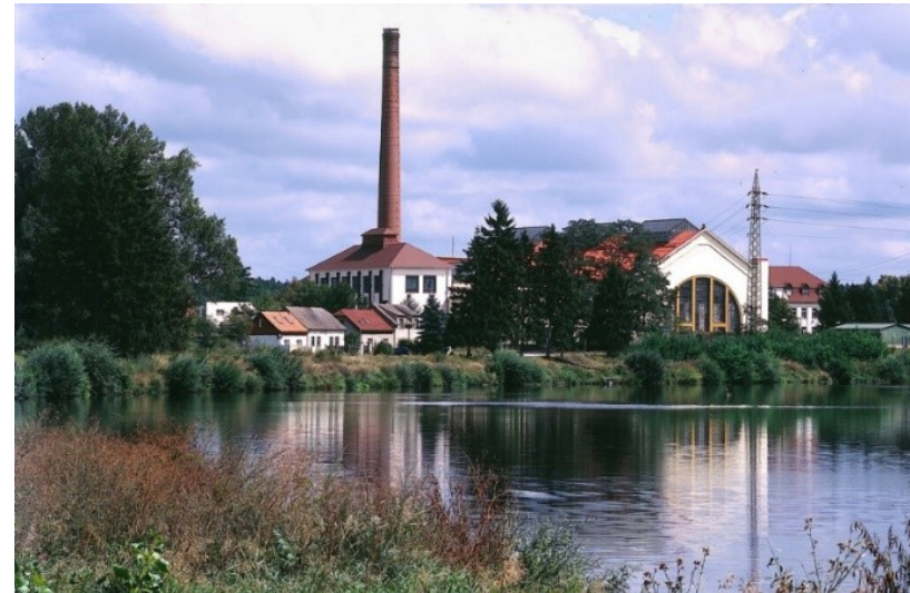
Úpravna vody Káraný (pvk.cz)
