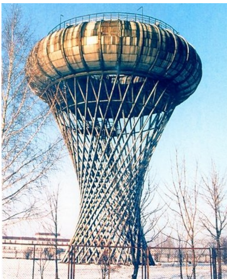
Vodojem na okraji Ciechanowa, Polsko
