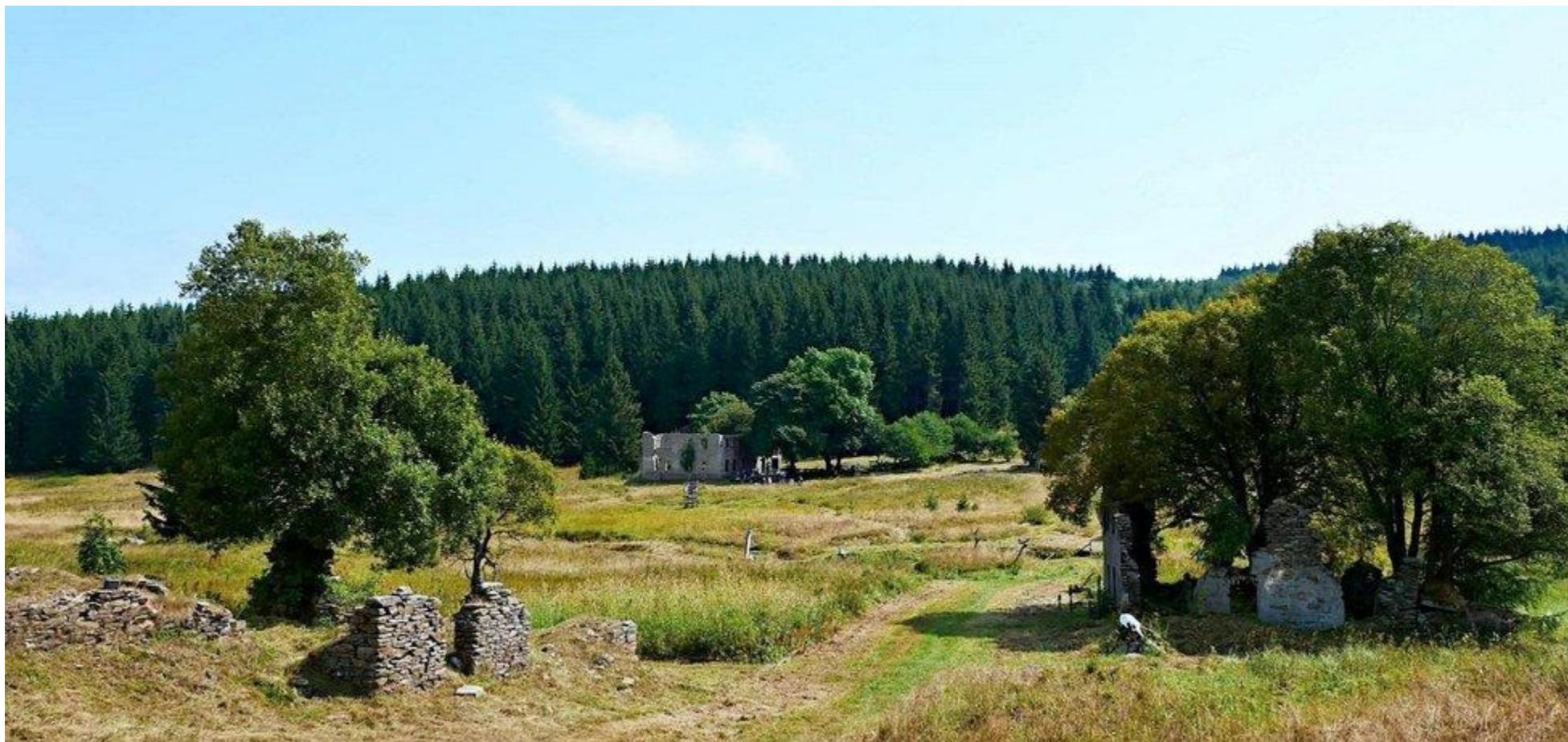
rozvaliny krušnohorské obce Königsmühle
