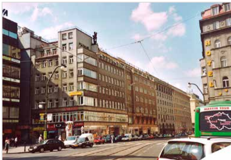
Obr. 10 Palác Kotva, kde v 6. nadzemním podlaží bylo v letech 1953 až 1957 dislokováno HLPÚ
