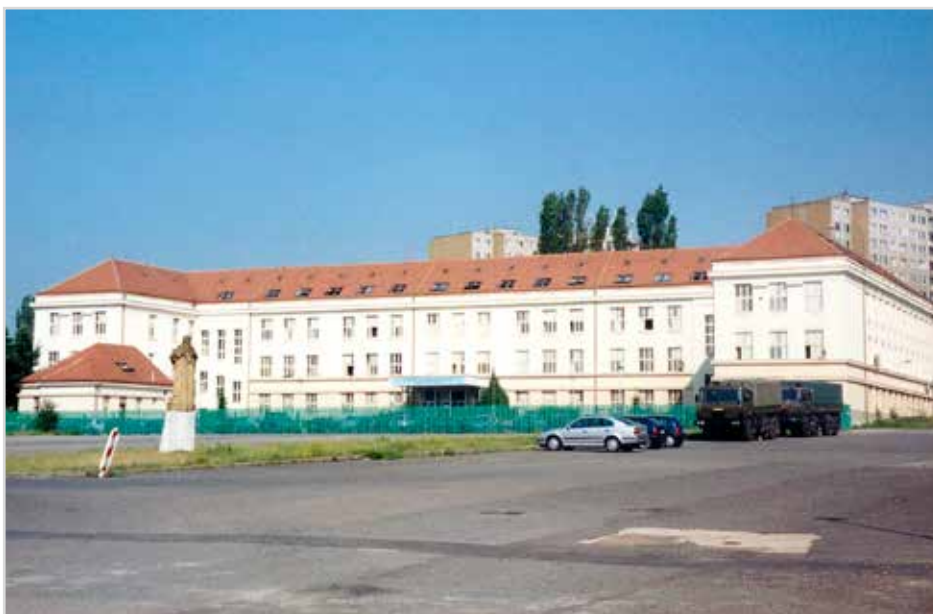
Obr. 14 Kasárna 17. listopadu v Praze-Ruzyni, kde v letech 1994 až 2003 bylo v prvním a druhém nadzemním podlaží dislokováno PÚ; v současnosti jsou zde dislokovány jeho nástupnické organizační složky VGHMÚř
